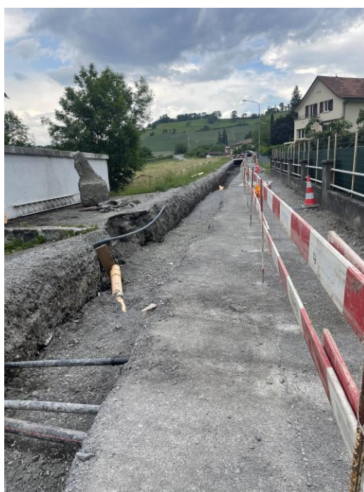
Mise en séparatif à la Route des Champs
