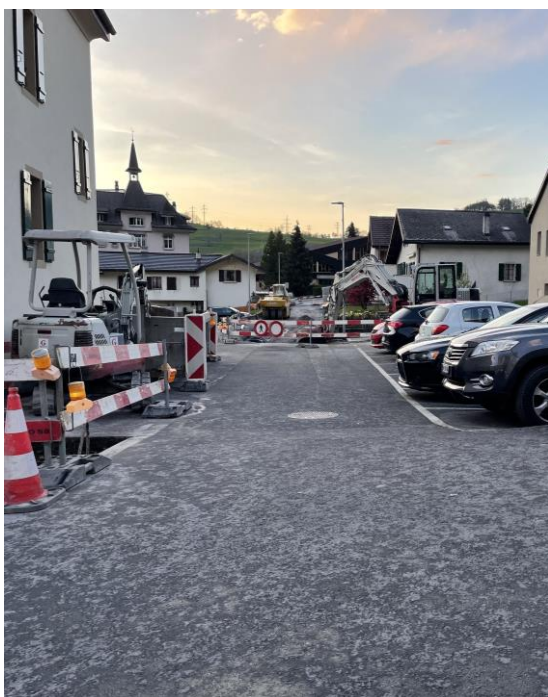
Mise en séparatif Chemin du Battoir
