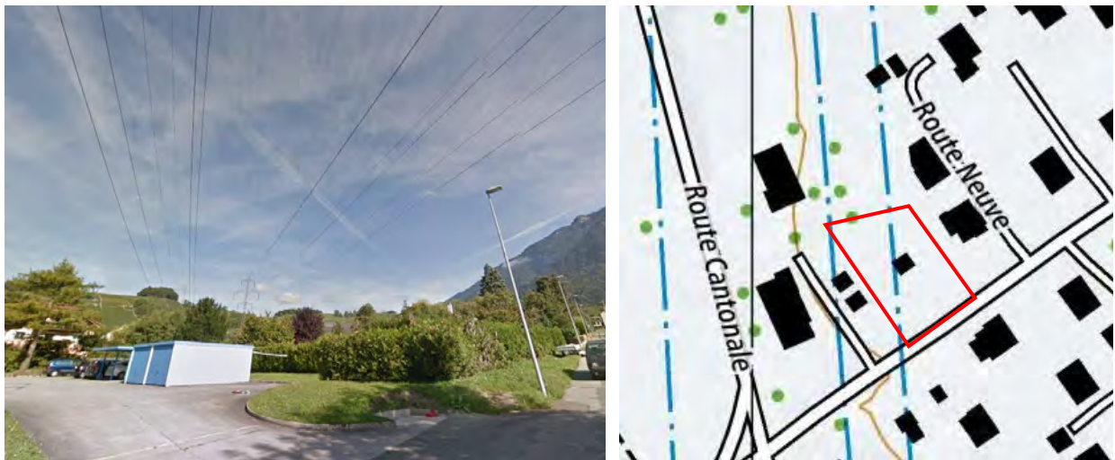
Figure 9 : Extrait de google maps montrant le passage de la ligne avec au premier plan, les garages présents sur la parcelle n° 320. Extrait de map.geo.admin montrant le passage de la ligne sur le secteur concerné.
